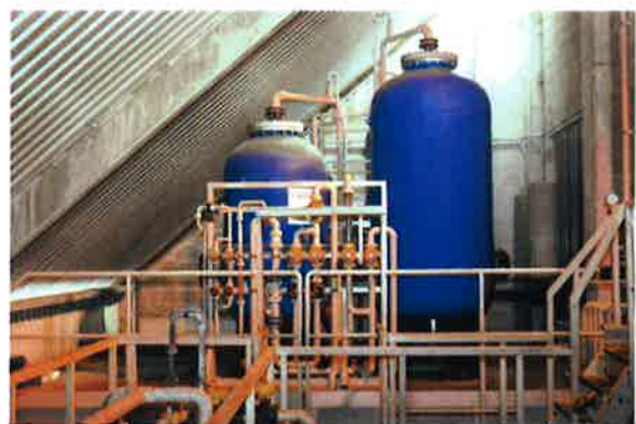
Les filtres à sable et à charbon actif
