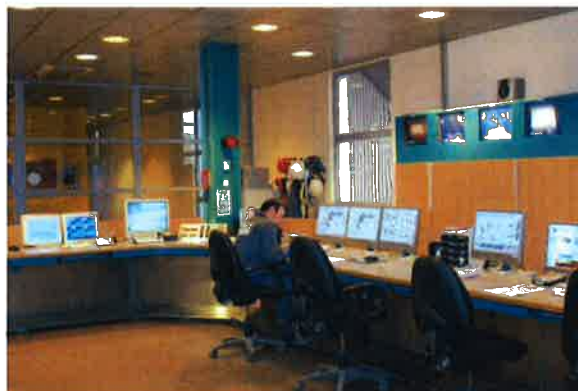
La salle de contrôle commande
