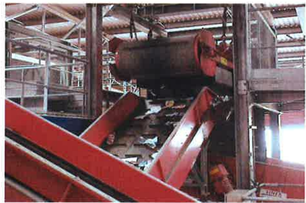
L'overband (tri magnétique des ferreux)
