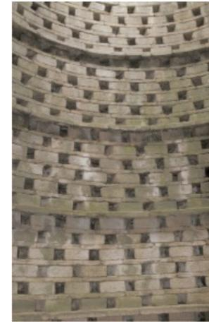
Les plus anciens sont construits en torchis autour d'une armature en bambous. Dans les pigeonniers les plus prestigieux, ce sont des assises de pierre creusées de niches en forme de « L » horizontal : abris profonds et recourbés pour cacher la nichée.
